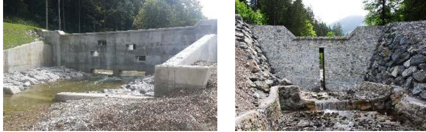
Şekil 8c – Sel kapanı amaçlı geçirgen tersip bentleri
