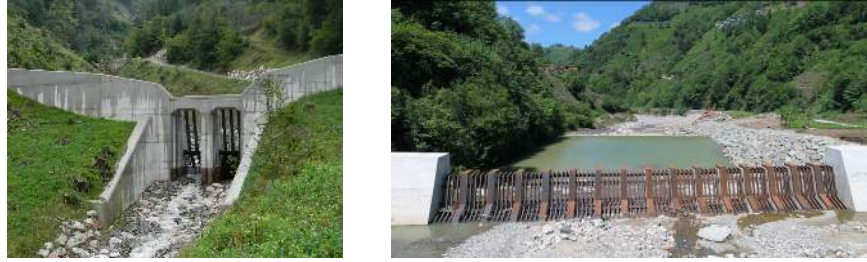
Şekil 8b – Ayıklayıcı amaçlı Geçirgen Tersip Bentleri
